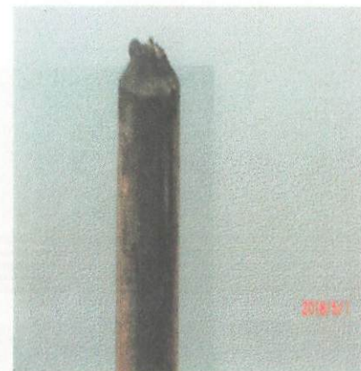
通常避雷針は5年経過で、 11回の落雷により大きな損傷
