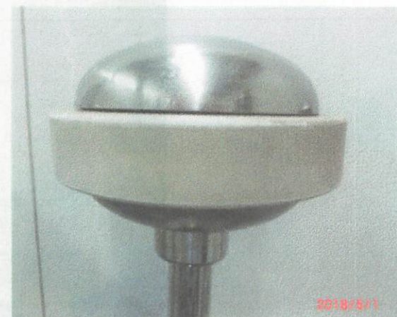
PDCE避雷針には損傷無し 落雷ゼロ
